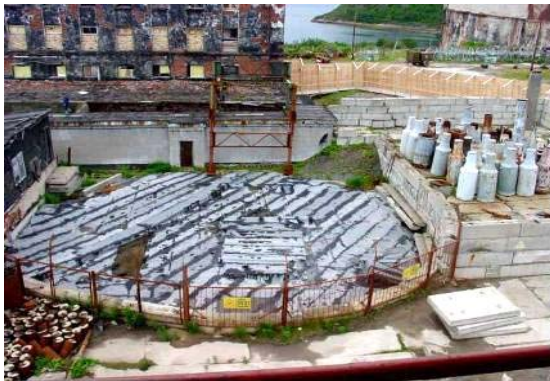
Загрязнённые бетонные плиты, изолированные битумом (состояние в 2002 году)
